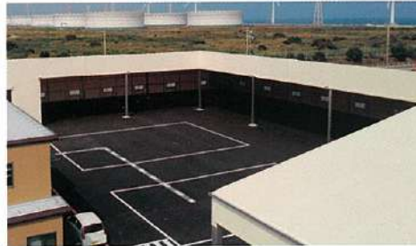
施工例：工場荷捌き場
