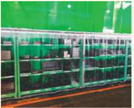
防塵 ビニールシート、D30レール、間仕切ポール使用 ⑦
