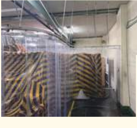
ビニールシート、D40レール使用 ⑩
