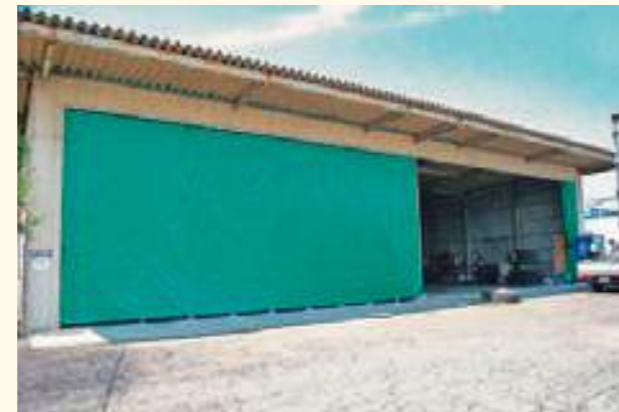
倉庫開口部 雨・風除け 防塵 テントシート、XGLレール、間仕切ポール使用
