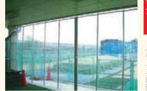
雨・風除け 防雪 ビニールシート、D30レール、間仕切ポール使用 ⑱
