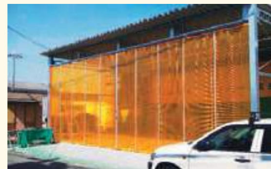
雨・風除け 防塵 防虫 ビニールシート(防虫)、D40レール、間仕切ポール使用
