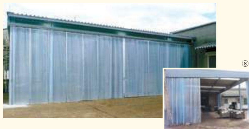
雨・風除け 防塵 ビニールシート、XGLレール、間仕切ポール使用
