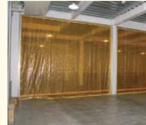
保温・保冷 飛散防止 防塵 ビニールシート、D40レール、間仕切ポール使用 ⑤
