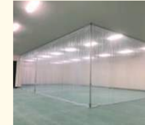
保温・保冷 防塵 防虫 ビニールシート、SGレール、間仕切ポール使用 ⑥
