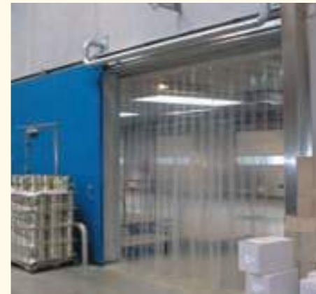
■ 倉庫内の間仕切 (冷蔵)
