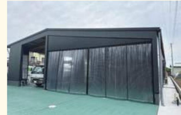
雨・風除け 防塵 ビニールシート、D40ブラックレール、間仕切ポール使用
