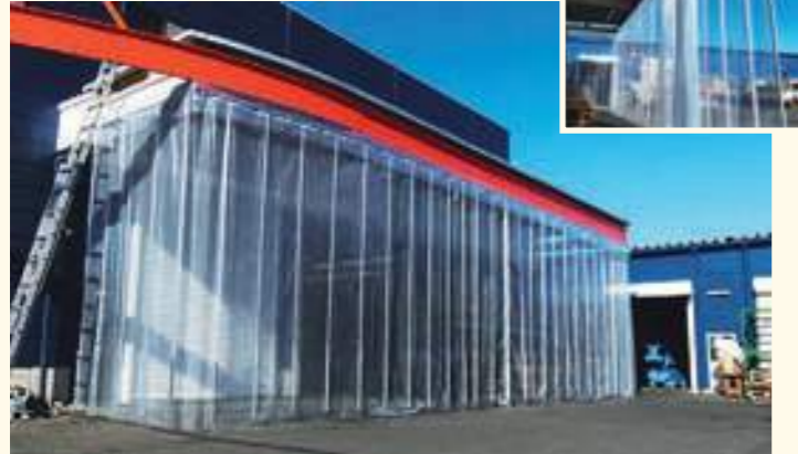
雨・風除け 防塵 ビニールシート、SGLレール、間仕切ポール使用
