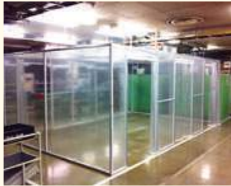
防塵 保温・保冷 ビニールシート、D40レール使用(シート扉) ③
