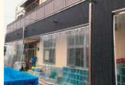
防塵 雨・風除け ビニールシート、D30レール使用 ⑰
