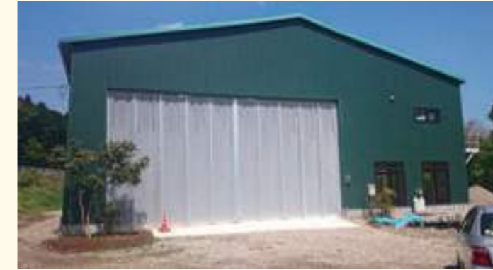
雨・風除け 防塵 ビニールシート、SGLレール、間仕切ポール使用
