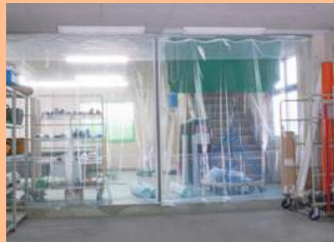
●倉庫内間仕切
