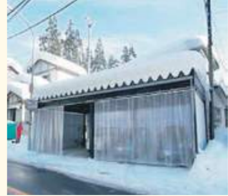
ビニールシート、D40レール使用 ⑲
