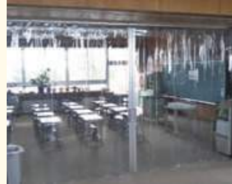
ビニールシート、D30レール、間仕切ポール使用 ㉒
