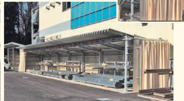
⑪ レールを90°曲加工、シート開放時に倉庫左右の側面に収納
