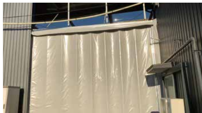
▲作業場の防寒対策
