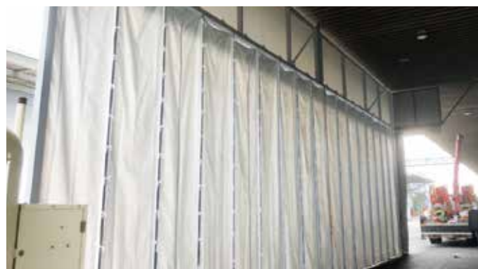
▲出荷製品の仮置き場
