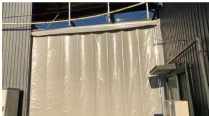
▲作業場の防寒対策
