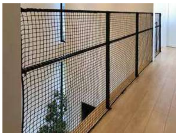
階段手すりネット取付例
