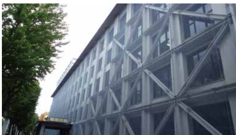
剥落防護ネット取付例
