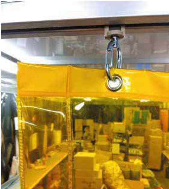
ポールの部分に補強のための共生地加工を当ててから取付
